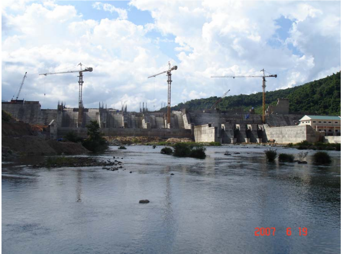
Hình 1. Toàn cảnh thi công đập BTĐL Định Bình
